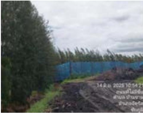
รูปที่ 15 การติดตั้งโครงเหล็กติดตั้งตาข่ายรอบลานกองเถ้า
