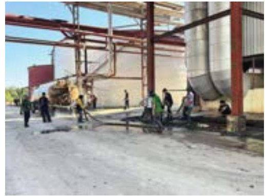
รูปที่ 24 การขุดลอกท่อระบบระบายน้ำในพื้นที่โครงการ
