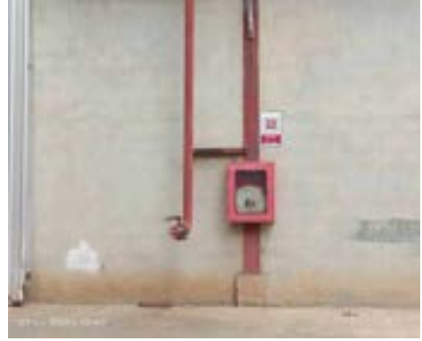
รูปที่ 61 ระบบท่อเย็น และหัวจ่ายน้ำดับเพลิง
