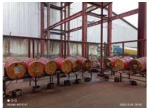
รูปที่ 30 การเทพื้นคอนกรีตในบริเวณที่วางถังกักเก็บน้ำมันโซล่า
