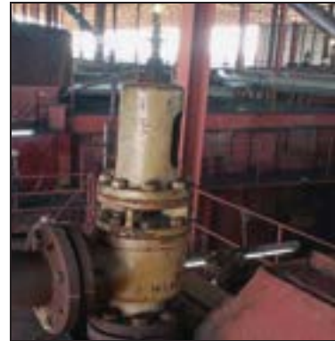
รูปที่ 90 อะไหล่ลิ้นนิรภัยของหม้อไอน้ำและกังหันไอน้ำ
